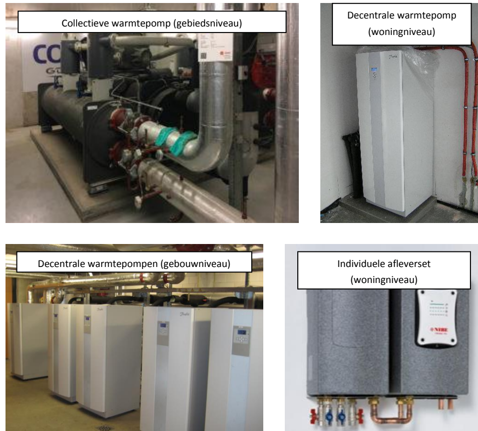
Figuur 11 - Impressie collectieve, decentrale warmtepompen (woningniveau en blokniveau) en afleverset
