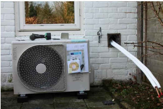
Figuur 25: Aanleg buitenunit lucht/water warmtepomp
