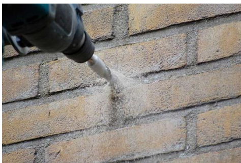
Figuur 58: Maatregelen aan woning spouwmuurisolatie
