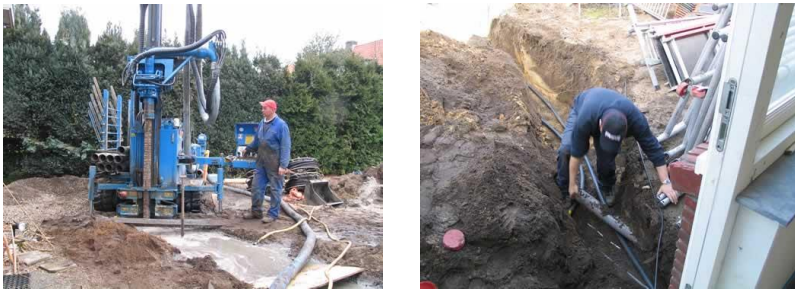
Figuur 28: Boring in tuin + aansluiting naar woning
