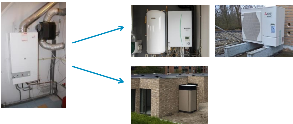
Figuur 24: CV-ketel vervangen door split systeem (rechtsboven) + geïntegreerde unit (rechtsonder)
