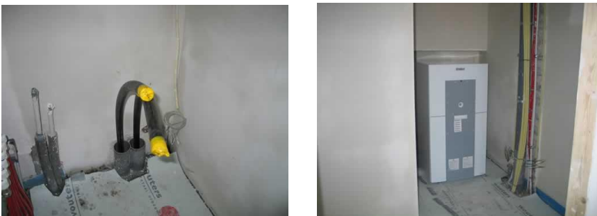
Figuur 29: Aansluiting leidingen in woning + plaatsen warmtepomp
