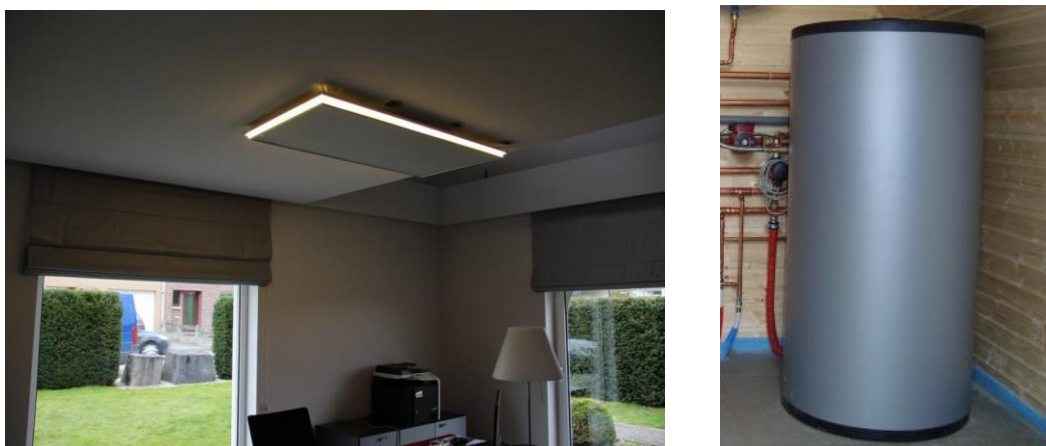
Figuur 7: rechts: IR-panelen voor verwarming en links: boiler voor warmtapwater
