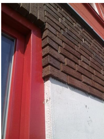
Figuur 20: buitengevelisolatie (links) nieuwe prefab gevel voor bestaand metselwerk (rechts)
