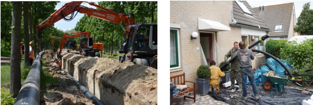
Figuur 31: Aanleg warmtenet op straatniveau en perceelsniveau
