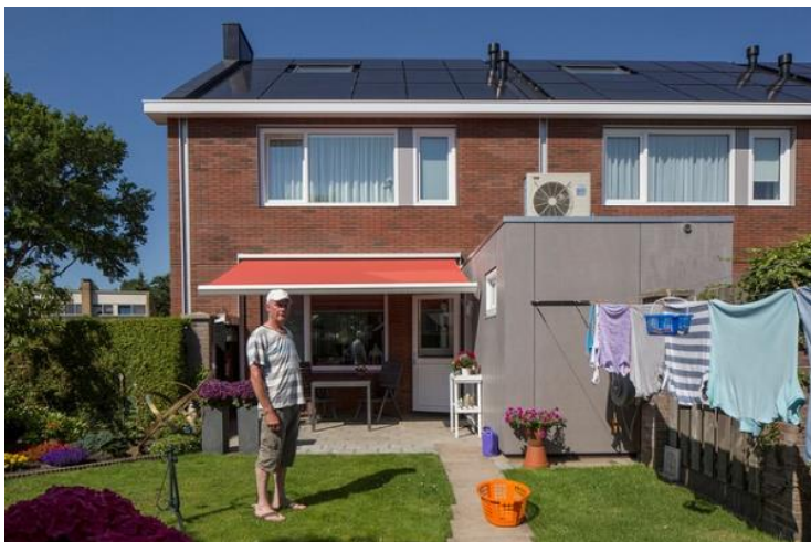
Figuur 59: NOM-woning met een lucht/water warmtepomp (bron: Stroomversnelling)
