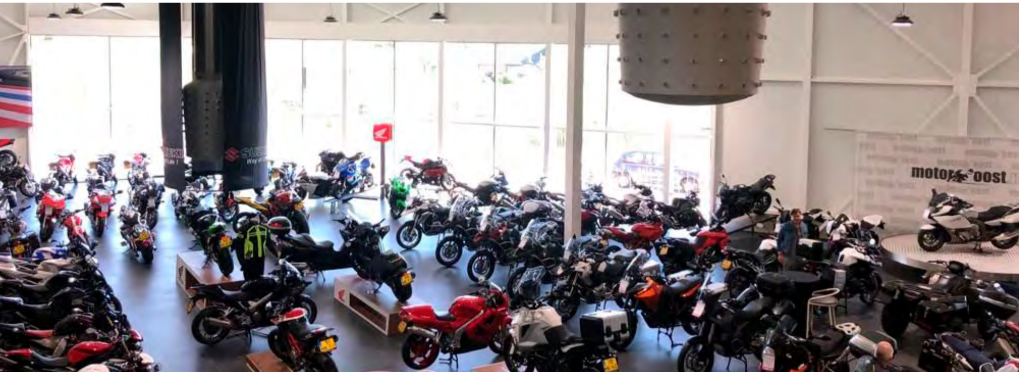
Afb. 9. Uitblaasopening van een adiabatisch koelsysteem in combinatie met (overdruk)ventilatie in een showroom (foto Oxycom - Motor Oost)
