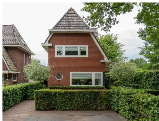
2. Vrijstaande woning (bouwjaar 1936)
