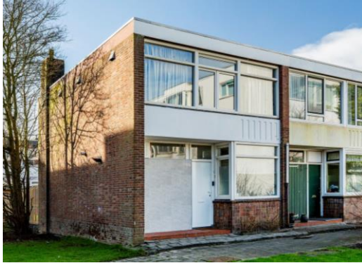
3. Grondgebonden woning plat dak (bouwjaar 1957)
