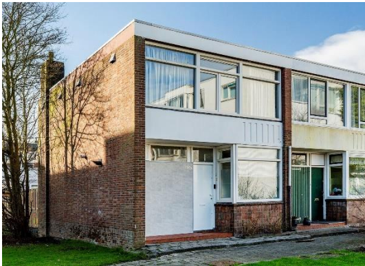
3. Hoekwoning plat dak (bouwjaar 1957)
