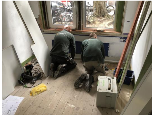
5 isowall is maat aanleveren en montageploeg instrueren
