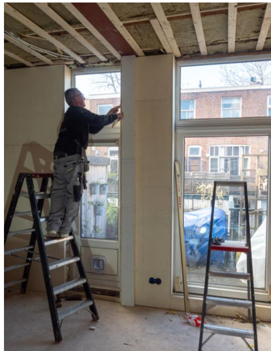
Voorbeeld van na-isolatie volgens de 'traditionele route'
