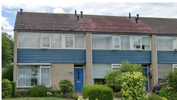
Figuur 4 Foto van de tussenwoning voor de renovatie
