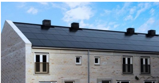
Dak-geïntegreerde zonnestroomsystemen (foto: AERspire/Heijmans)
