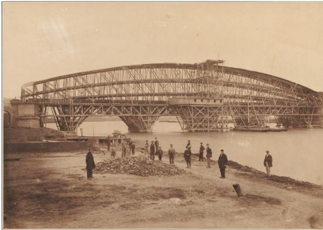
Spoorbrug bij Culemborg in aanbouw
